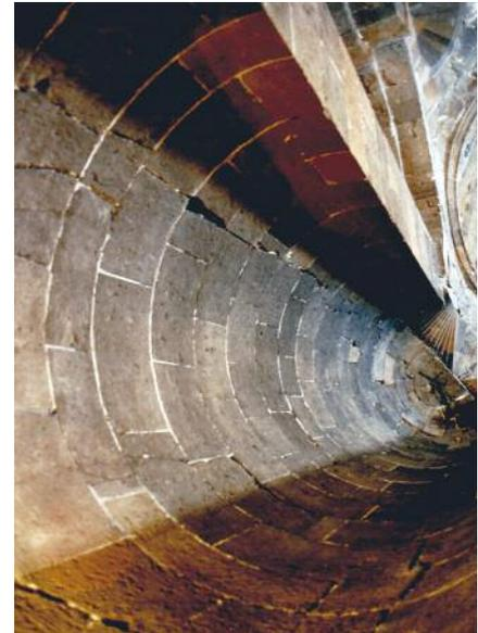
Fig. 9 Chiesa di S. Hripsimè, rinforzo semicilindrico interno.
