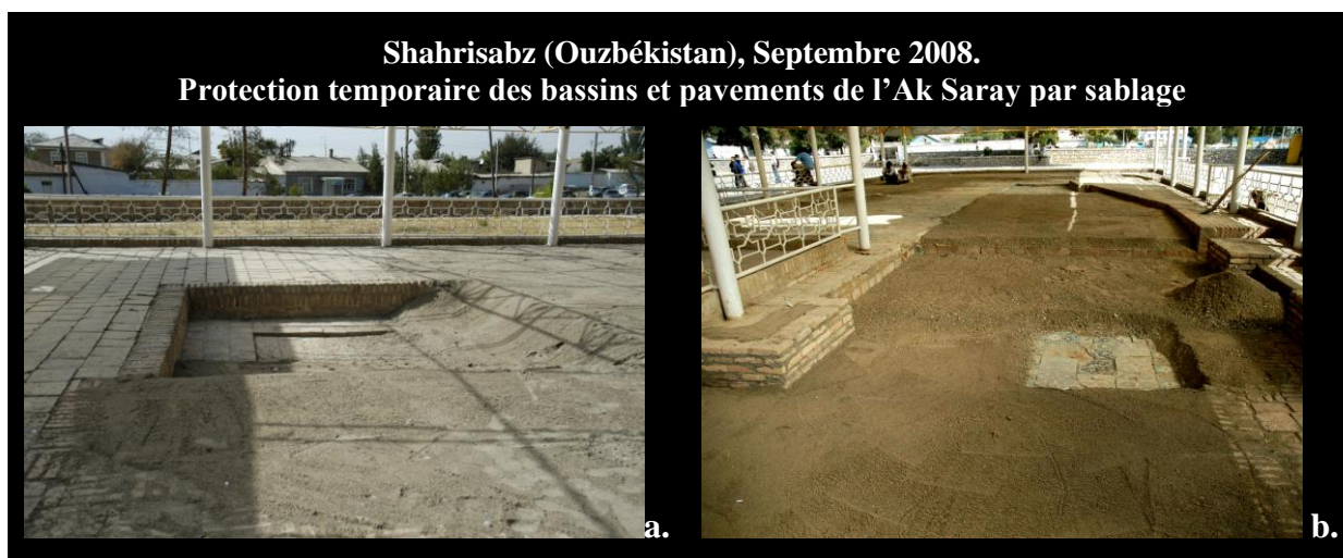
Figure n 159 : Protection en septembre 2008, à l'aide de sable, de la zone des bassins et pavements glaçurés du palais de l'Ak Saray, en vue de les protéger des écarts thermiques excessifs et de l'eau (neige, eau liquide, glace).
